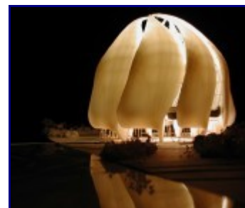
Bahá'í Huis van Aanbidding, Santiago, Chili (in aanbouw)
